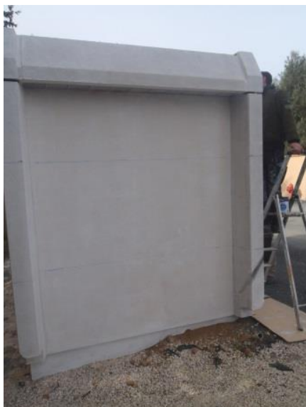
Préparation du support avec l'application d'une sous couche et le traçage de repères.
