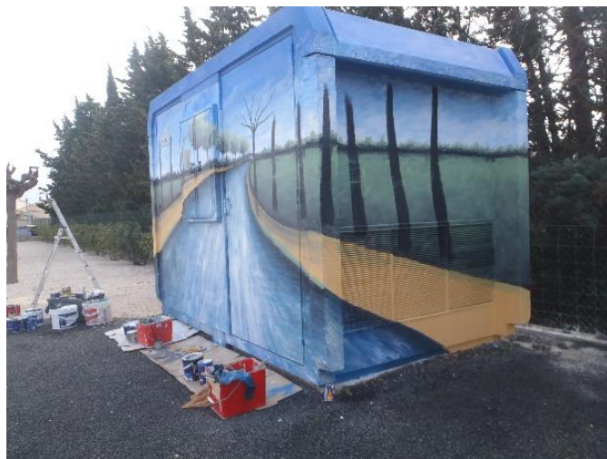
Mise en peinture du transformateur.
