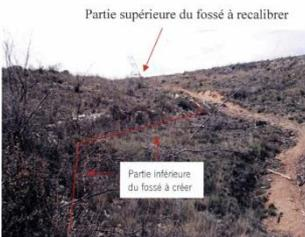
Evacuation sur la partie inférieure du chemin de l'eau pluviale vers les lieux dits « Cabrière » par une rigole maçonné en pierres.
