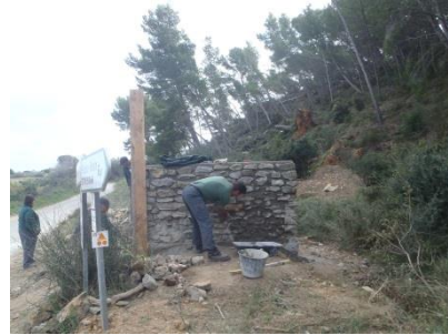
Lissage des joints.
