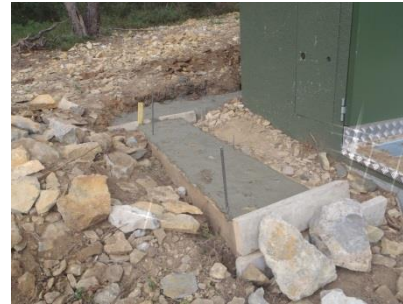
Coulage du béton.
