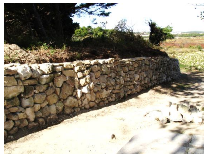
COUPE D'UN MUR DE SOUTÈNEMENT DE TERRASSE DE CULTURE
