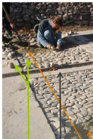
pierres rigole d'écoulement remblai
