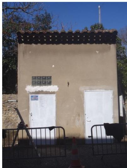
Un enduit est appliqué sur l'ancien emplacement des tuiles permettant de lisser la paroi ainsi qu'une couche d'apprêt spécifique sur les parties métalliques et plastiques.
