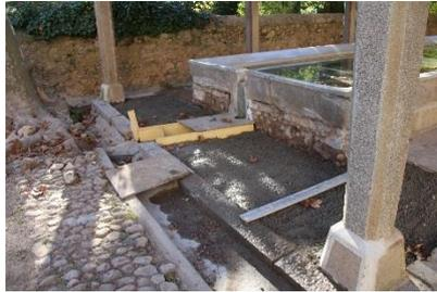
Dans un premier temps, une couche de béton d'une épaisseur de 10 cm est coulée.
