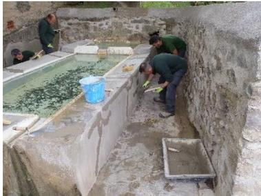
Les fissures du lavoir sont repérées puis colmatées à l'aide de mortier.
