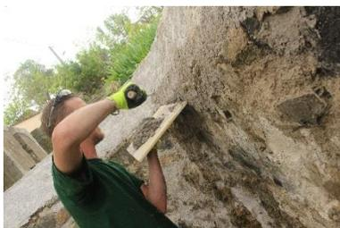
Un raccord au mortier à la chaux est réalisé entre la couvertine et le mur afin d'avoir un meilleur rendu.
