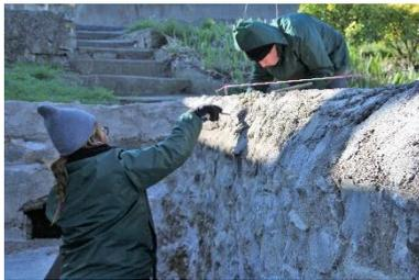
La couvertine est reconstruite à l'aide de pierres et de mortier à la chaux. Un cordeau tendu permet d'avoir un repère pour rester en retrait de 2 cm du point le plus haut afin de réaliser la couche de finition.
