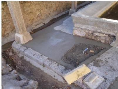
Réalisation d'un glacis\* : finition par saupoudrage de ciment pur.
