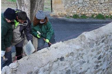
Démontage de la **couvertine\*** à l'aide d'un burin et d'une massette en vue de la restaurer.
