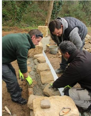
Mise en place du premier rang de pierres sur le devant de la banquette (partie visible) et contrôle de l'alignement des pierres avec une règle de maçon\*.
