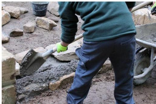
Remplissage de la partie centrale de la banquette avec du béton afin de sceller les deux rangées de pierres.
