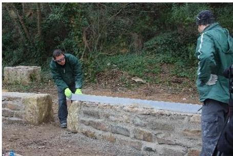
Contrôle du niveau de la croute de mortier à la chaux par rapport aux deux pierres de taille de chaque côté à l'aide d'une règle.
