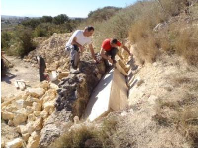
Préparation du *mortier*\* pour la couverture de l'enceinte
