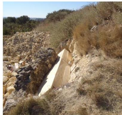
✚ Mise en place du *coffrage*\* pour la construction du toit
