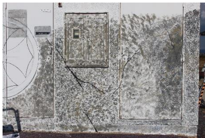
Tracé des fissures.
