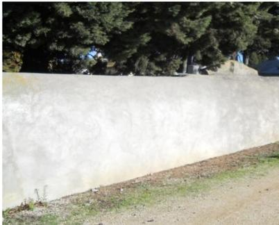
✚ Pose du *badigeon*\* en deux couches sur les parties restaurées du mur d'enceinte.
