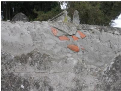
Des morceaux de briques et des pierres récupérés *in situ*\* sont utilisés afin de combler les manques.
