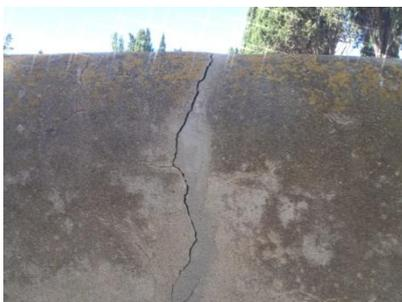
Le rebouchage des fissures se fait à partir d'un enduit à la chaux. Une 1<sup>ère</sup> accroche est posée. Après séchage à l'air libre, et suivant le résultat obtenu, une 2<sup>ème</sup>, voire 3<sup>ème</sup> couche sera posée.
