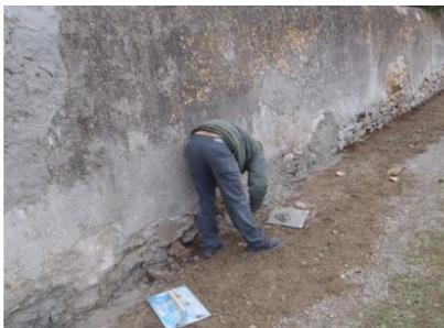
L'enduit sera appliqué à l'aide d'une taloche en laissant sécher.
