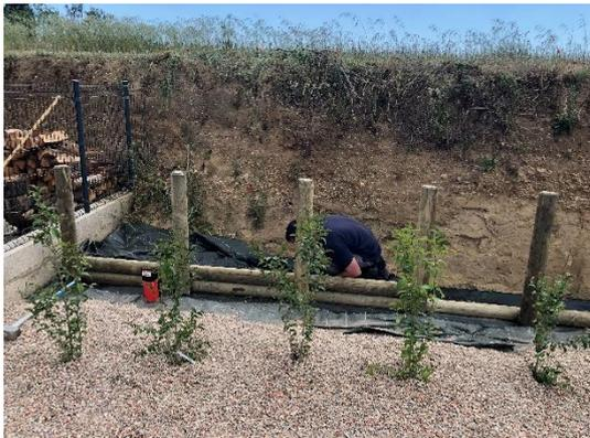
Afin de limiter la prolifération des adventices, pose d'un **géotextile\*** dans la continuité des graviers. Il passe sous le muret de rondins et remontera sur l'arrière du mur de soutènement
