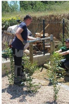
Après avoir réalisé les trous d'une profondeur de 50cm à l'aide de la tarière, les poteaux en rondins sont implantés : ils sont rentrés en force dans les trous à l'aide d'une masse.
