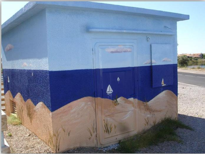
Les fissures et autres imperfections ont été rebouchées avec un enduit puis une sous couche a été appliquée pour rendre homogène l'application des peintures « trompe l'œil ».
