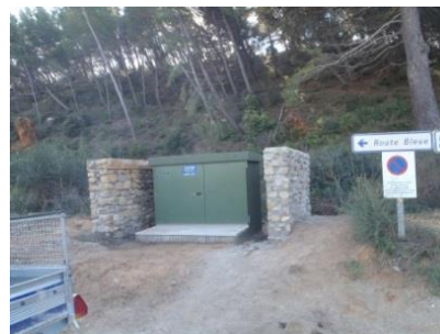
Vue d'ensemble des murets finis
