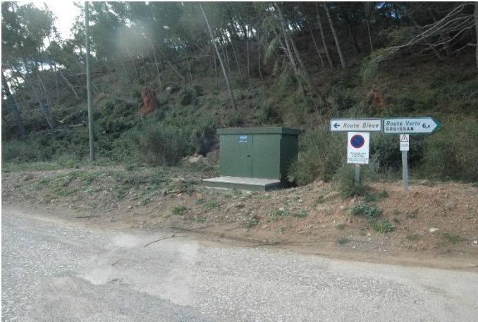
Transformateur avant travaux.
