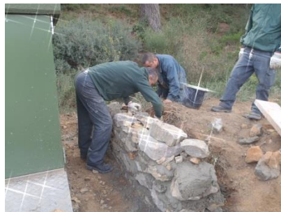
Scellement de pierres au mortier.
