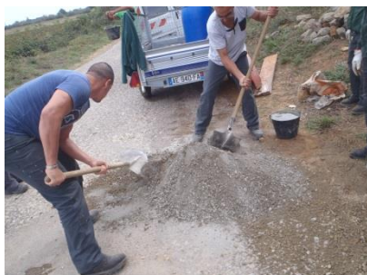
Préparation du béton de fondation.
