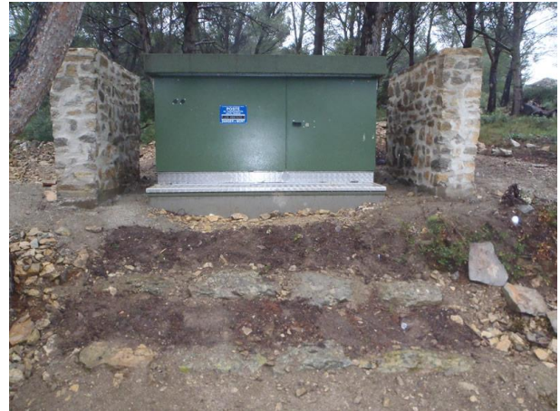
Transformateur après l'intervention de l'équipe d'IDEAL
