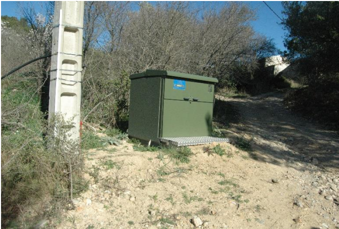
Transformateur avant travaux
