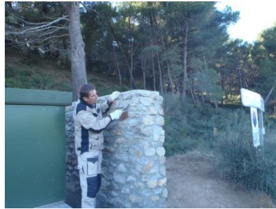
Finition des joints à la brosse métallique.
