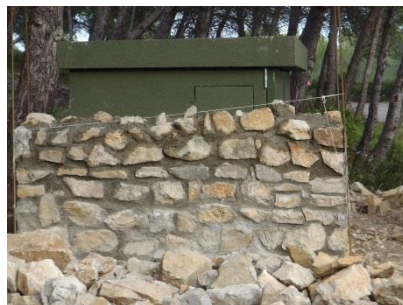
Réalisation des joints.
