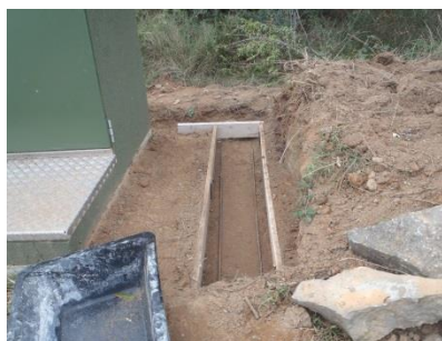
Fabrication du coffrage de fondation.
