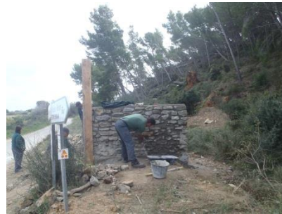
Lissage des joints.
