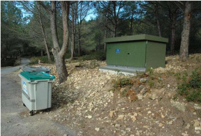
Transformateur avant travaux
