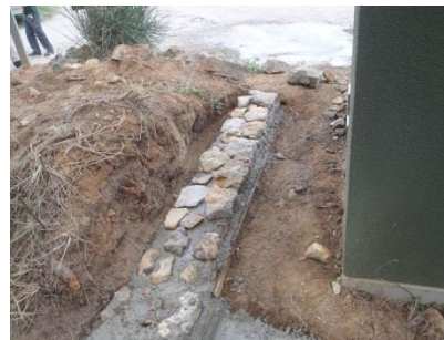
Mise en place de la deuxième rangée de pierres.
