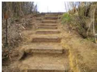
Exemple de réalisation (traverses de chemin de fer)
