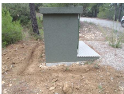
Creusement de la fouille de fondation.
