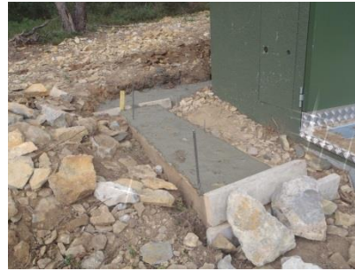
Coulage du béton.
