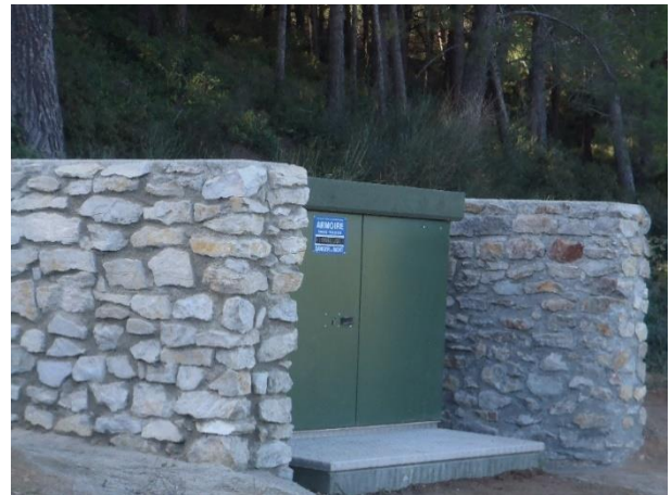
Transformateur après l'intervention de l'équipe d'IDEAL.
