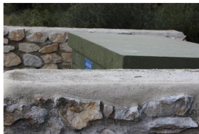
Les arases terminées.
