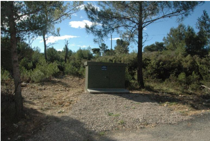
Transformateur avant travaux.
