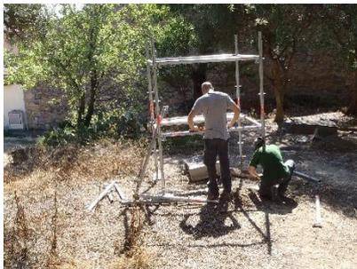
Tour à tour l'échafaudage est monté afin de permettre d'hisser les blocs à l'aide d'un *palan*\* manuel et de sangles ...
