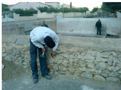
L'équipe entame maintenant les différents travaux de maçonnerie : repiquage des pierres du mur d'enceinte...
