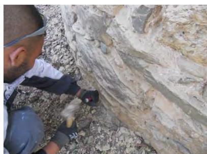
... soit, pour les parties de l'édifice les moins accessibles, manuellement à l'aide d'un marteau et d'un burin ou d'un ciseau à pierre.
