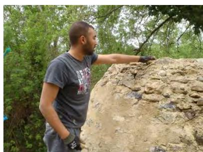
Elles sont scellées au mortier à la chaux. Il permet une meilleure adhérence au support et assurera une longévité dans le temps.
