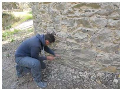
Les travaux de rénovations commencent par un décroûtage des parties les plus fragiles : *corniches\**, joints (résistance moindre)...
