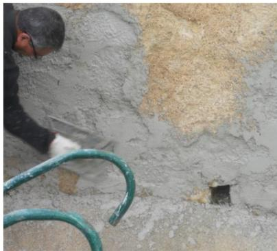
Lissage du dépôt de chaux à l'aide de la taloche.
