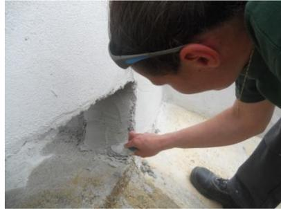
Utilisation d'une taloche dite « langue de chat » afin d'appliquer la chaux dans la partie creuse de l'épanchoir.
