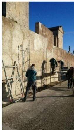
Mise en place du premier cadre et pose du garde-corps de l'échafaudage
