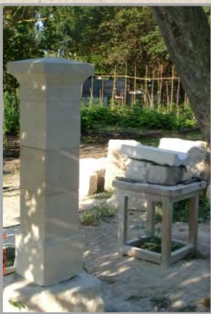
Construction de la colonne
