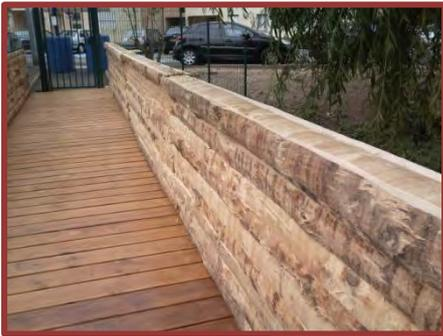
*Du bois d'épicéa (peu onéreux) a été choisi pour remplacer le plancher, conçu en autoporté pour ne pas abîmer la structure support (le bois provient de la Haute Vallée de l'Aude).*
