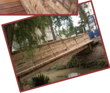
*Ce bois étant brut, un léger ponçage a été réalisé afin de limiter le risque d'échardes. Des renforts métalliques ont été « habillés » de fines cordelettes tressées afin d'imiter au mieux le style moyenâgeux.*
