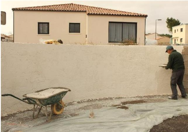
➤ Après avoir passé une première couche d'enduit de façade sur l'intérieur du mur, une seconde couche d'une épaisseur de 5mm est appliquée à l'aide de taloches. Après un séchage de 5 heures environ (selon la météo) l'enduit est lissé à la taloche éponge ★.
