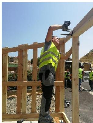
L'encadrement de l'entrée est fixé à la traverse supérieure et au socle par des vis.
