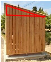
Pignon                  | Partie haute et triangulaire d'un mur, entre les deux versants d'un toit.                                                                                                                                                                                                                     |
