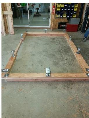
Dix pieds métalliques réglables en hauteur sont fixés sur la lisse\* basse de l'abribus. Le fait qu'ils soient réglables permettra d'ajuster le niveau du socle sur la dalle béton.
