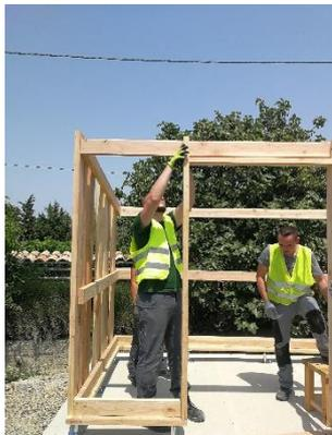
Pose des traverses horizontales et de l'encadrement de l'entrée.
