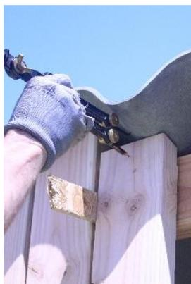
La pointe du compas est positionnée sous la PST ; la mine quant à elle, est positionnée sur la pièce de bois. Le compas est déplacé perpendiculairement à la PST en suivant la courbe afin de reporter la forme sur la pièce de bois. Cette technique se nomme « le traînage ».
