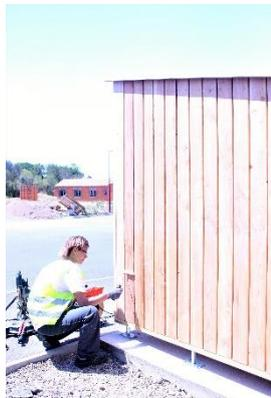
Application au rouleau d'un verni antigraffiti sur l'ensemble de l'ouvrage afin de le protéger de potentielles futures dégradations.
