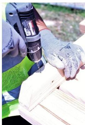
Assemblage des pièces à l'aide de vis avec un pré-perçage réalisé au préalable.
