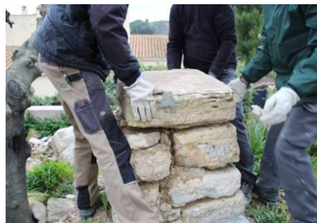
Scellement de la « première pierre supérieure » du socle.
