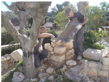
Re-scellement et rejointoyage des pierres.
