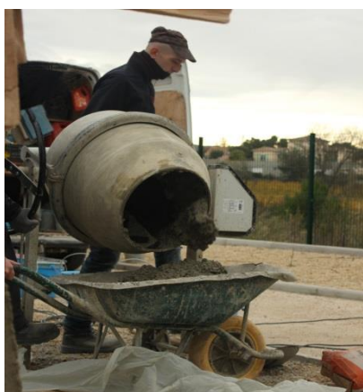
Préparation du béton.
