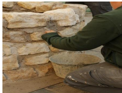
Réalisation des joints à la chaux*
