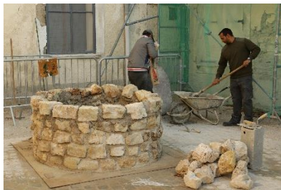
Préparation du mortier pour la pose des pierres.
