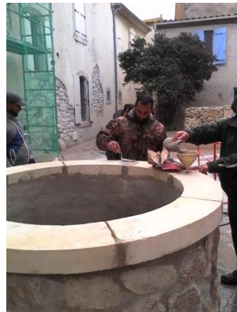
Finition : réalisation des joints des margelles.
