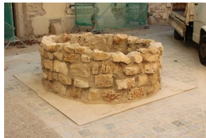
Le puits au trois quarts monté.
