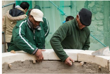
Pose de la dernière margelle.
