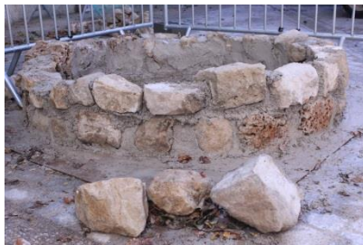
Les deux premiers rangs montés : vue de face.
