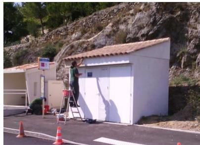
L'ensemble des parois est recouvert par une sous-couche d'accrochage.
