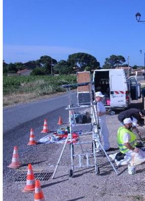
Afin de travailler en toute sécurité, le chantier est balisé avec des cônes, au moins un salarié porte un gilet de sécurité et une plateforme sécurisée est utilisée pour le travail en hauteur.
