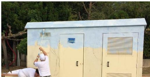
Le travail de la peinture est réalisé « en fondu » avec la perche et le rouleau, cela signifie que les différentes couleurs sont mélangées directement sur le support.
