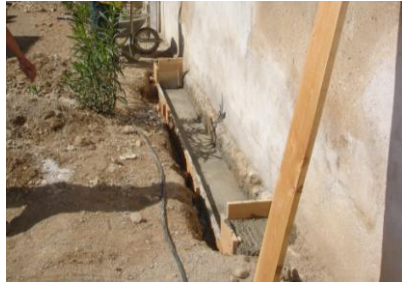
Les chapes sont coulées...
