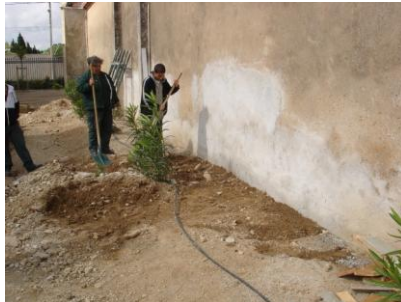
L'enduit ayant été réalisé en amont, le terrain est prêt pour la pose des ogives...
