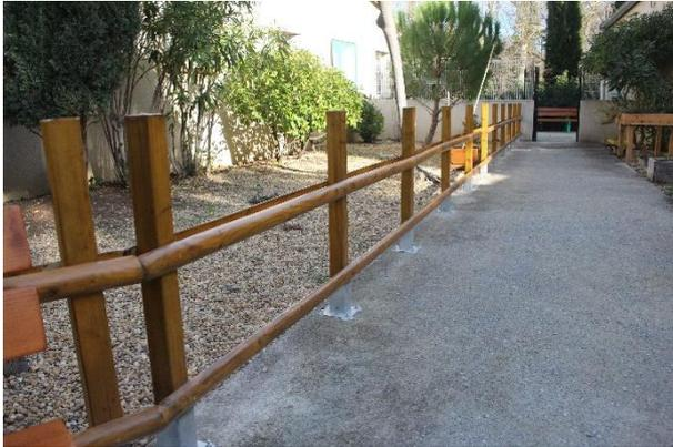
Démontage de la lisse supérieure existante de 70mm de large pour la remplacer par une de 100mm.
