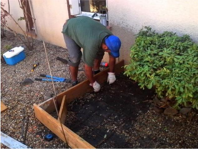
Installation du coffrage et du treillis soudé.
