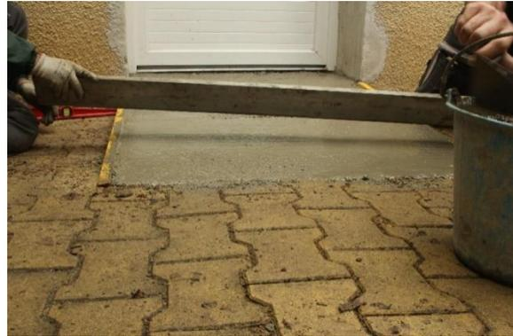
Lissage de la dalle béton.
