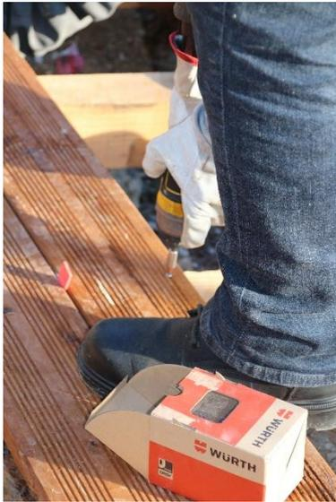
Une cale de 2mm est utilisée pour permettre de régler les écarts.
