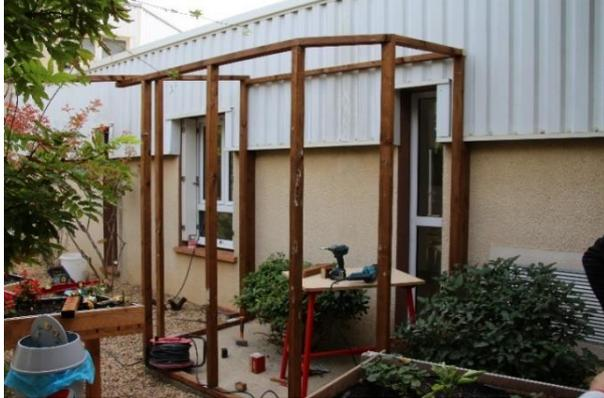
Construction du châssis de la volière sur la chape en béton à partir de poteaux et *lisses*\* hautes et basses en *pin autoclave classe 4\**.
