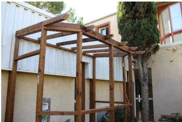
Pose des chevrons sur la partie haute de la volière en guise de charpente.
