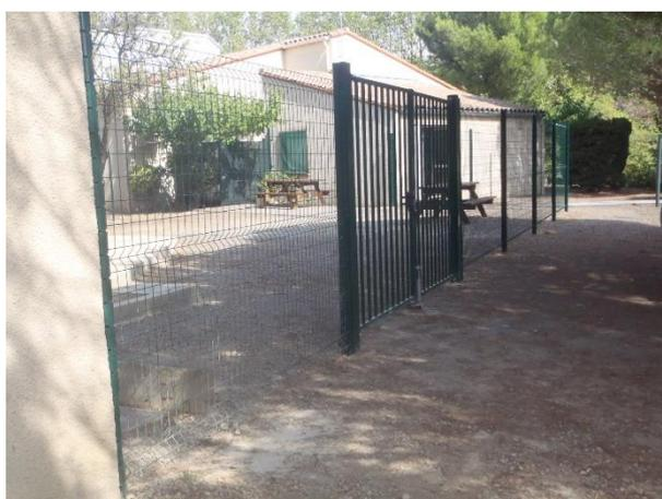
Une fois les poteaux scellés dans le béton, pose du portail et du grillage.
