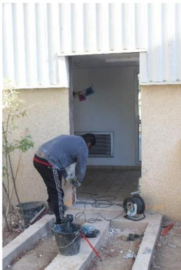
L'ouverture du mur a été réalisée à l'aide d'une disqueuse électrique.
