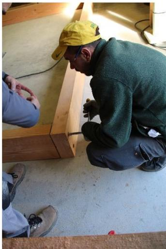
Réalisation du cadre du kiosque (sablère) et fixation par des tirefonds de 20cm de long et un diamètre de 10mm (2 tirefonds par côté).
