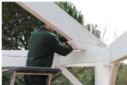
Pose et fixation de l'arête.
