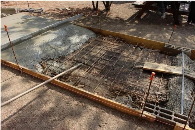
Pose d'un *treillis soudé*\* avant le coulage du béton qui sera tiré à la règle pour le mettre à niveau.
