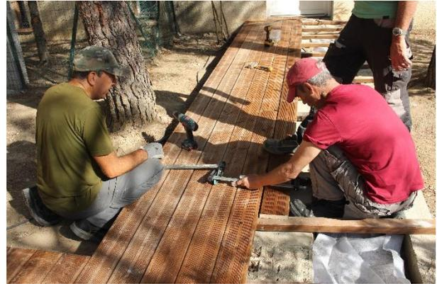
Mise en place des lames avant vissage.
