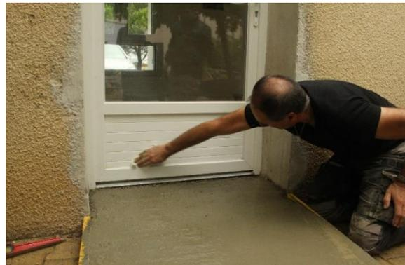
Nettoyage des projections de béton.
