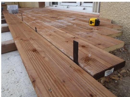
Pose des lames et vissage.
