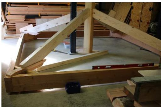
Fin de la pose des 4 arêtiers bloqués à leurs extrémités par le poinçon d'un côté et le **berceau de sablière\*** de l'autre.
