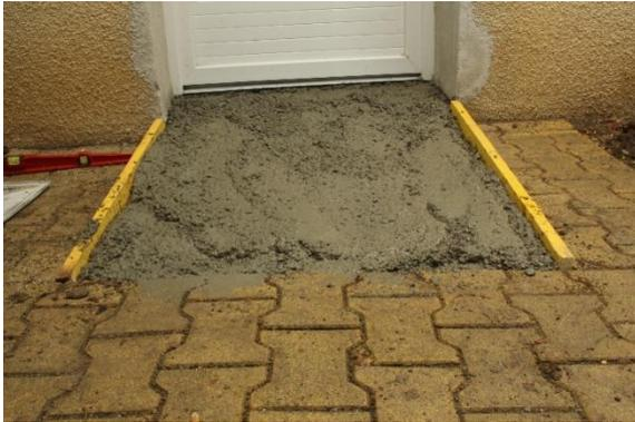
Coffrage terminé, coulage de la rampe d'accès à la porte fenêtrée.
