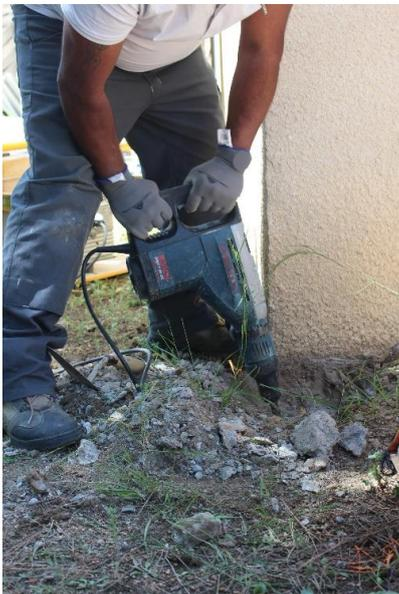
Utilisation d'un perforateur afin d'enlever un bloc de béton gênant pour la pose d'un poteau de la clôture.
