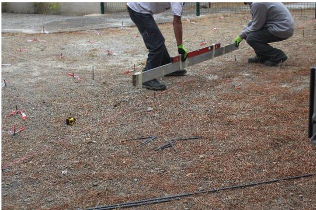
Vérification du niveau à l'aide d'un *cordeau*\*, d'une règle en aluminium et d'un niveau.
