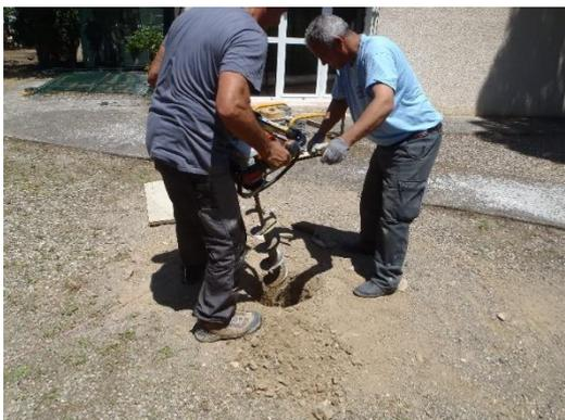
Utilisation d'une *tarière thermique\** pour creuser les trous dans la terre.
