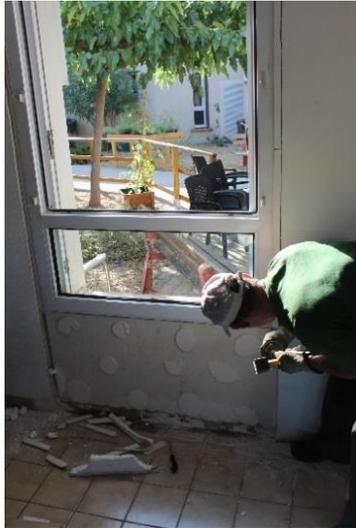
Pour la dépose de la fenêtre, le **Placoplatre®** est découpé afin d'accéder aux pattes de fixation de la fenêtre sur le bâti.
