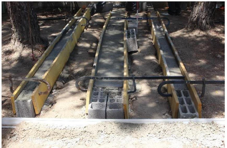
Vue d'une partie des coffrages à l'intérieur desquels le béton est coulé.
