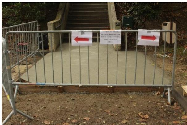
Mise en place d'un coffrage et coulage de la dalle béton.
