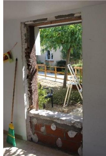
Enlèvement de la fenêtre qui sera remplacée par une porte fenêtre.
