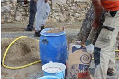
Les joints sont réalisés à l'aide d'un *mortier*\* à base de *chaux*\*. L'équipe prépare ce dernier en respectant les proportions déterminées par l'encadrant.
