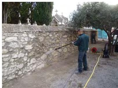
Avant d'en entamer le rejointoiment, les murs sont humidifiés afin d'aider l'*enduit*\* à adhérer aux joints restants.
