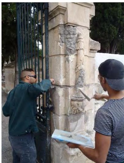
... les manques comblés à l'aide d'un mortier à la chaux.
