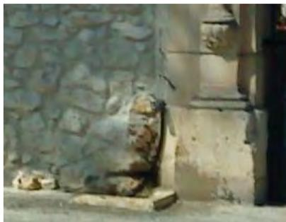
Le trou en résultant est comblé par des pierres identiques à celles utilisées pour la construction du mur.
