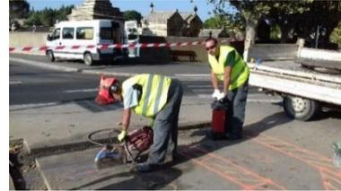
Creusement des fouilles de 25cm de profondeur pour couler les fondations.
