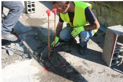
Dépose d'un lit de mortier sur la fondation pour sceller les parpaings.
