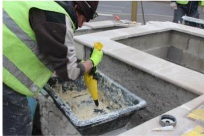
Utilisation d'une *douille*\* pour remplir les joints.
