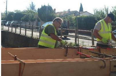
Une *arase*\* est réalisée afin de mettre l'ensemble des murets de la jardinière de niveau ; pour cela un coffrage est réalisé.
