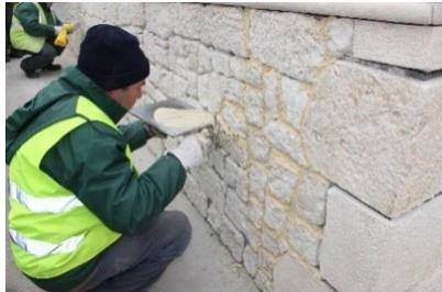
Une autre méthode est utilisée pour le remplissage des joints : l'utilisation de la langue de chat et de la taloche.
