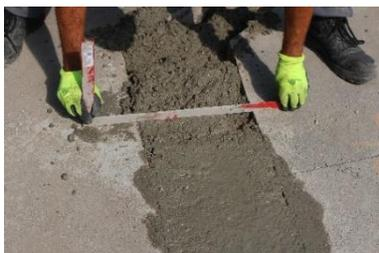
Le béton est tiré afin d'être mis de niveau.
