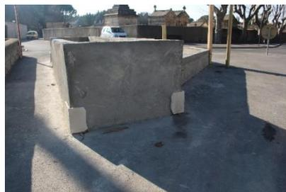
Fixation des pierres d'angles à la colle mortier.
