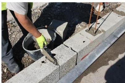
Entre chaque parpaing un joint en mortier est coulé afin de sceller les parpaings les uns aux autres. Une langue de chat est utilisée pour tasser le mortier.
