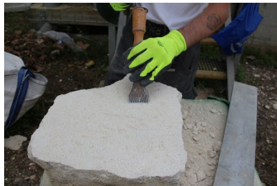
Dégauchissage de la pierre au ciseau grain d'orge*.
