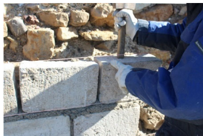
Espacement de 1cm entre chaque pierre pour jointoyer.
