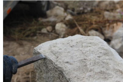
Dégauchissage* de la pierre au ciseau plat*.
