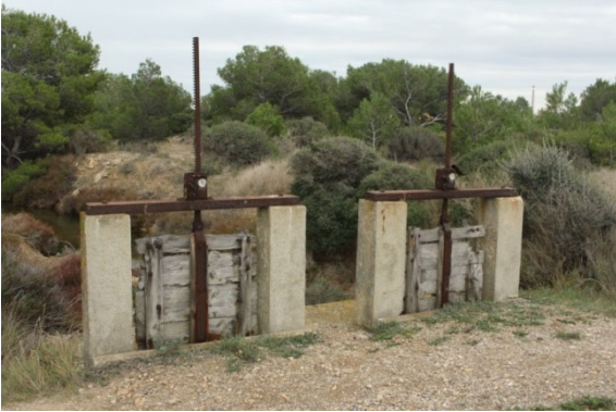
Les martelières (vannes guillotine)
