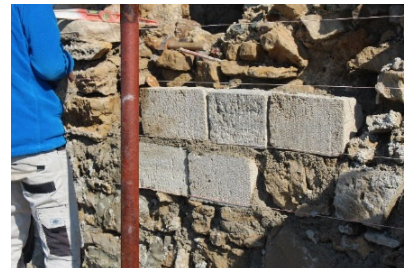
Pose de la deuxième rangée terminée.
