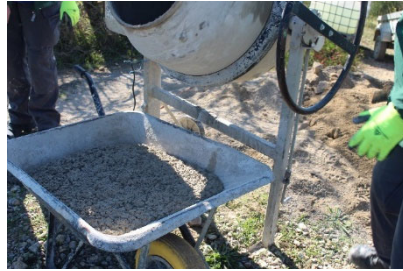
Préparation du mortier à la chaux.
