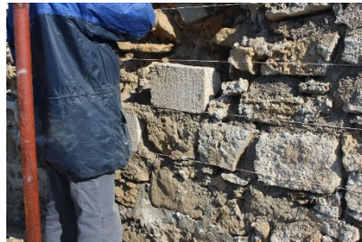
Pose de la première rangée de pierre delimitée par un cordeau.
