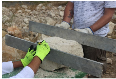
Traçage pour effectuer une face plane et droite.
