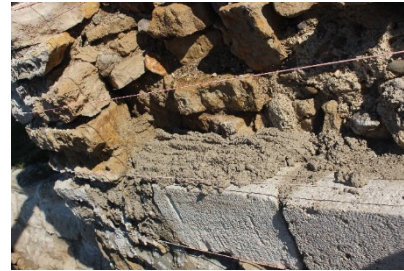
Tassement du mortier pour la pose des pierres.
