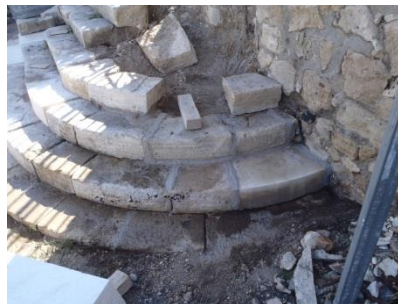
Vue d'ensemble du côté droit
