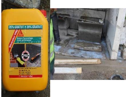
Badigeonnage d'une résine d'accrochage pour permettre l'adhérence du béton sur l'ancienne chape.
