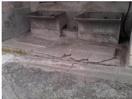
Démolition et réflexion de l'ancienne dalle béton du lavoir.
