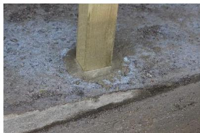
Scellement des chevrons dans la dalle béton (réalisée par la suite).
