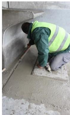
Réalisation d'une petite rigole d'évacuation au pied du bac sur le même principe.
