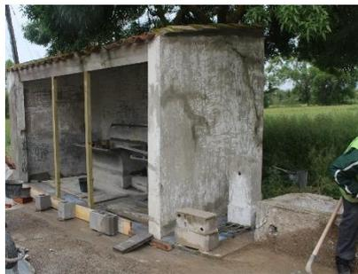
Réalisation d'un coffrage à l'aide de planches avant le coulage de la dalle.
