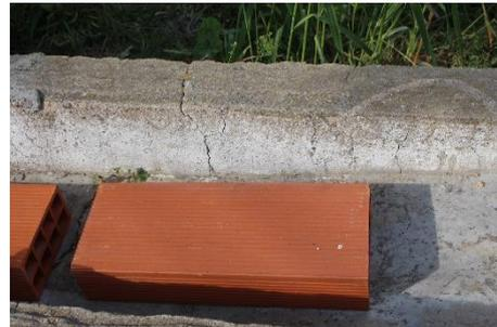
Maçonnage des assises des bacs et enduit du bâti réalisé au mortier de ciment.
