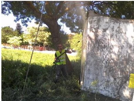
Nettoyage des murs du lavoir à l'aide d'un nettoyeur haute pression.
