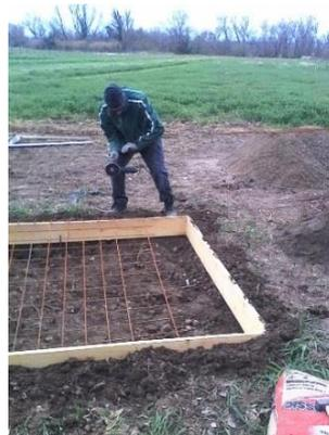
La dalle est armée d'un **treillis soudé\***. Il est découpé à la meuleuse aux dimensions du coffrage avant le coulage du béton afin qu'il soit aux bonnes dimensions.
