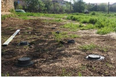
Coulage de plots en béton dans des tubes PVC en vue de fixer les tables.
