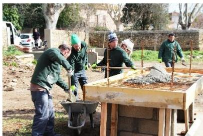
Remplissage du coffrage avec le mortier.
