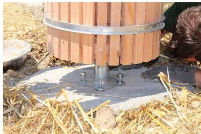
... de tire fonds pour les fixer. Des rondelles sont utilisées pour régler le niveau.
