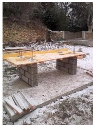
Mise en place du coffrage sur les jambages en parpaings et réalisation du contour du coffrage.
