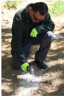
Les chevilles à frapper sont fixées dans le béton sec à l'aide d'un marteau.
