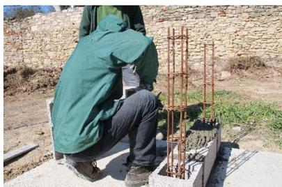
Entre chaque parpaing, sur le même rang, des joints en mortier sont réalisés et entre chaque rang de parpaings, une couche de mortier est mise en guise de colle.
