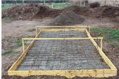
Le treillis soudé coupé au préalable est positionné.
