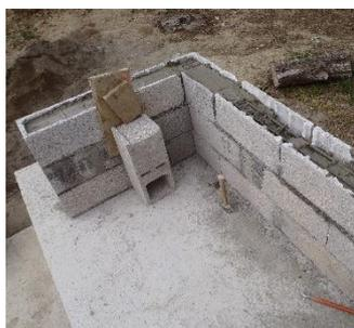
Sur le dernier rang, des parpaings en U sont utilisés afin de réaliser une ceinture en béton armé.
