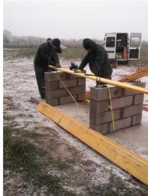
Les planches de coffrage sont mesurées et découpées en vue de réaliser le plan de travail.
