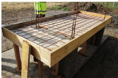
Une bâche a été installée sur le fond du coffrage pour éviter au mortier de s'infiltrer dans les interstices des planches de coffrage, puis un treillis soudé est installé en vue d'armer le plan de travail.
