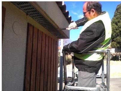
Réparation d'une fissure : grattage et colmatage.
