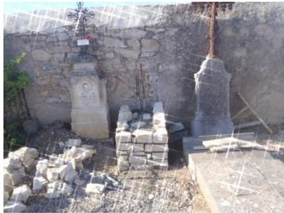
À chaque rang de pierres monté, l'intérieur est rempli de béton et de grosses *gravettes*\*.
