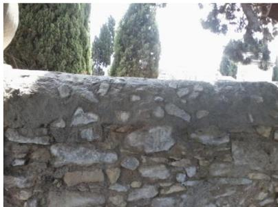
Pour le chapeau, l'étanchéité a son sens pour protéger la maçonnerie. C'est au maximum l'agencement des pierres qui doit assurer le ruissellement : pas de plats horizontaux en mortier.
