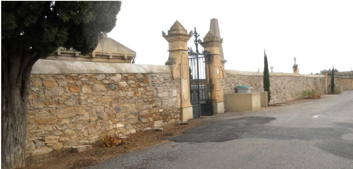
Au fil des saisons et des intempéries, le mur de l'enceinte se dégrade, s'effrite, s'affaisse. Ses joints disparaissent...
