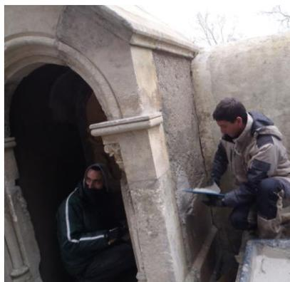
Il est temps d'enduire et de lisser les murs intérieurs et extérieurs avec du mortier à base de sable et de ciment. Cela confortera la stabilité de la station.
