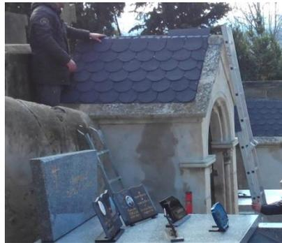
La pose des tuiles thermoformées finalise la réfection de la toiture.
