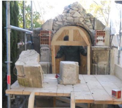
Une fois les colonnes reposées, l'équipe installe un coffrage qui reprend la forme du monument. Ce dernier a été réalisé sur mesure par l'équipe de l'atelier bois d'IDEAL.
