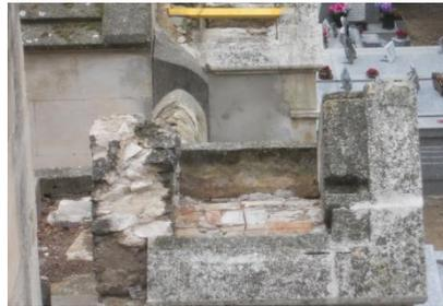
Une fois mis à nu, il s'avère que la partie du mur arrière supportant le toit devra être renforcé par l'ajout de pierres...
