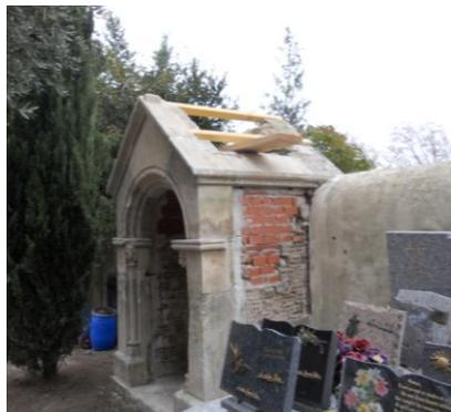
L'ossature de la charpente est terminée. Scellée à la colle à bois, il faut la laisser sécher avant l'installation des autres supports qui permettront la finalisation du toit.
