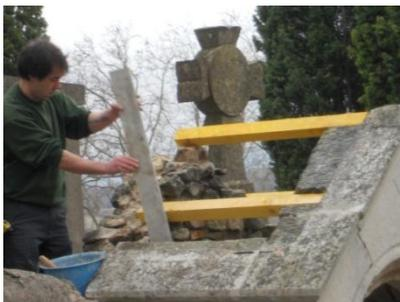
Fixées à l'aide de mortier à la chaux, les pierres ajoutées confortent la stabilité de la construction avant la pose du plan bois et du shingle.
