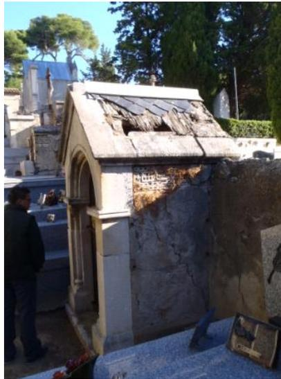
L'étape "mise hors d'eau" est nécessaire avant d'effectuer l'enduit intérieur de la station. Le toit actuel, fragilisé par l'usure du temps, doit être entièrement enlevé.
