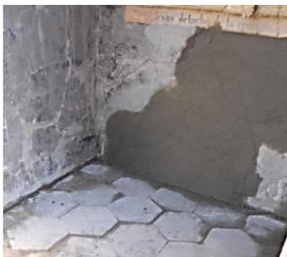
Les tomettes se déchaussant, l'équipe a décidé de les repositionner en utilisant les techniques et les matériaux d'origine.
