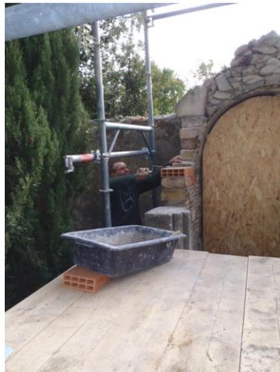
La restauration du mur est effectuée à l'aide des matériaux récupérés sur place, de briques et de *mortier*\*.
