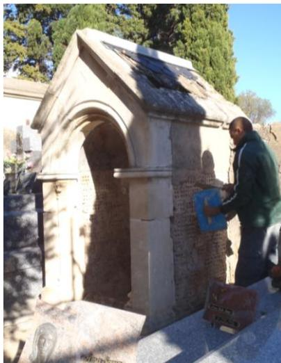
Il est par la suite enduit avec du mortier de sable et de ciment (consolidation et imperméabilisation).
