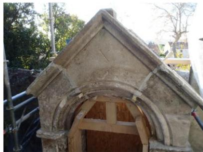
Une fois la voûte posée, il faut créer un joint de consolidation pour unir chaque partie (voûte, arcs, colonne...). Celui-ci est réalisé par *coulinage*\* à l'aide d'un mortier à la chaux.
