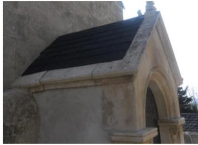
Les tuiles sont posées mais n'ayant plus de shingle de forme arrondie, elles seront de formes carrées jusqu'à réception du modèle utilisé sur les autres stations.
